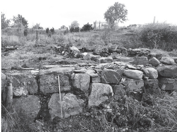
Рис. 3. Церковь Рождества Богородицы. Фундамент церкви. Вид с севера. 2013 год. Фото М. Шахновича
