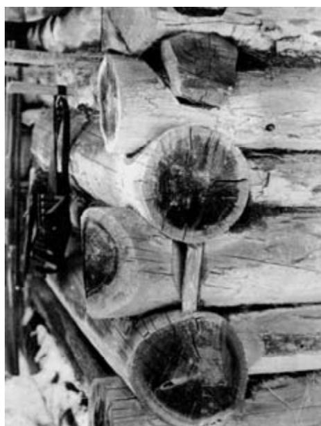
Рис. 3. Угол сруба промыслово-охотничьего стана на Лешозере в Карелии, сложенного «в погон». По месту использовано дополнительное укрепление углового соединения бревен деревянным штырем-упором [12; 234]
